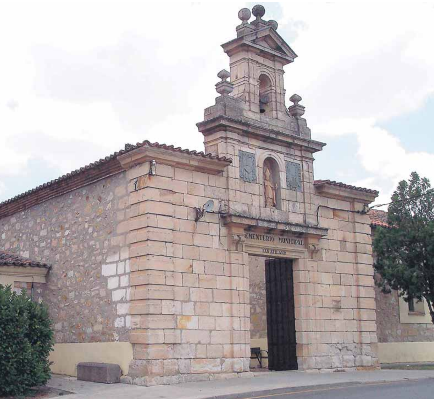
Vista exterior del cementerio
